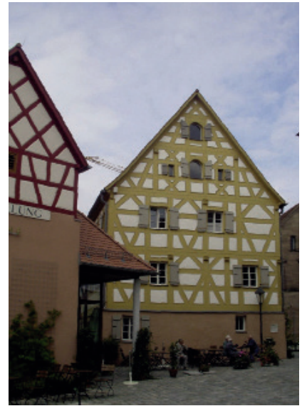
Das Markgrafenschlösslein in Georgensgmünd, in dem die „Saazer Stube“ untergebracht ist (Foto: Förderverein Saaz)
